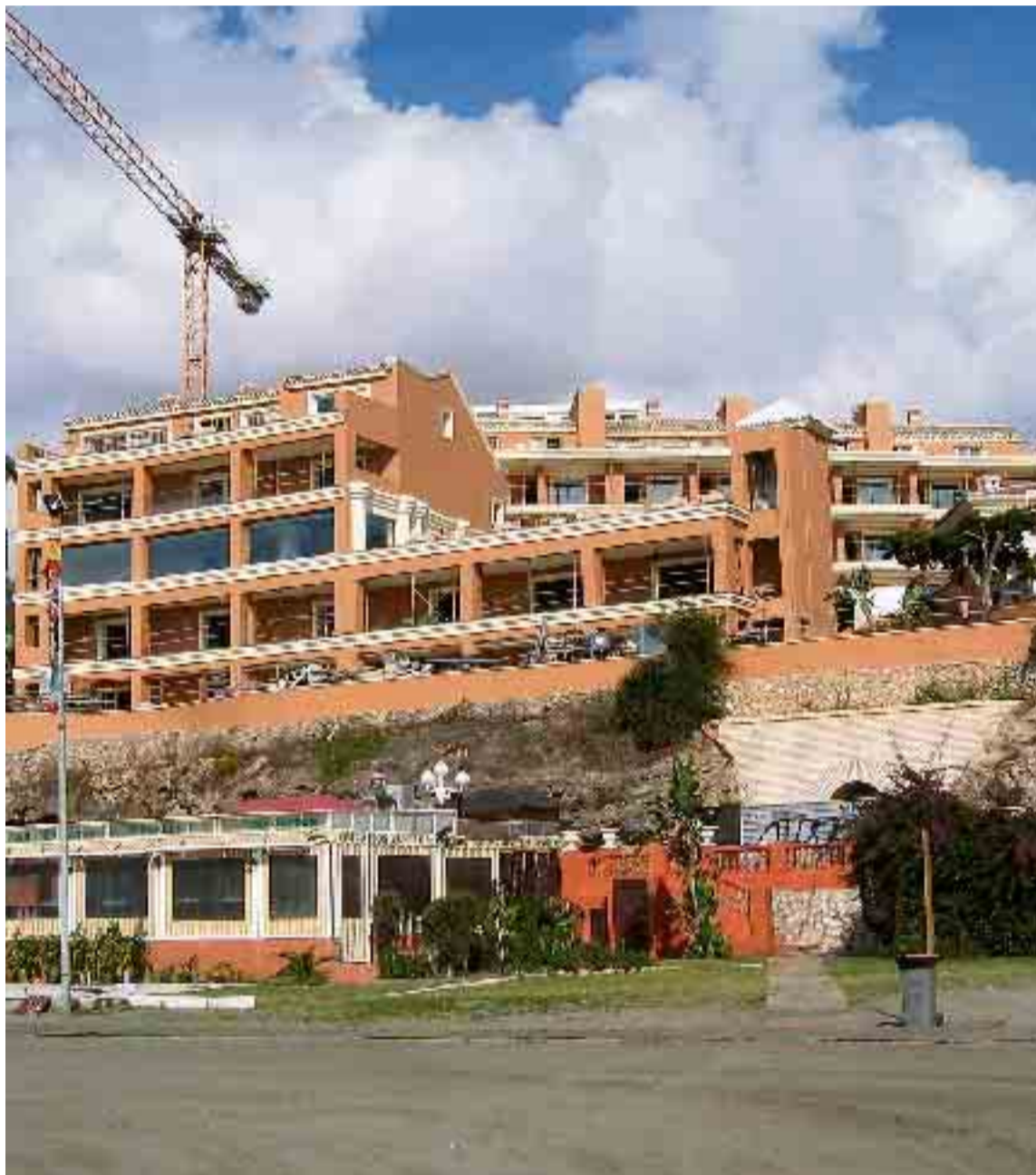
Las obras concluirán a finales de año, de forma que podría abrir sus puertas en primavera. :: F. JIMÉNEZ
