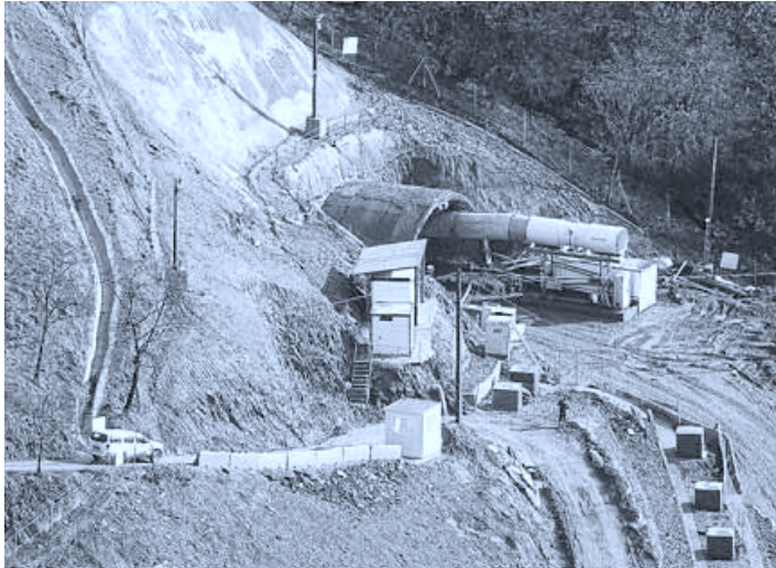
Máquinas trabajan en las obras de construcción del Tren de Alta Velocidad. FOTO: N.G.
