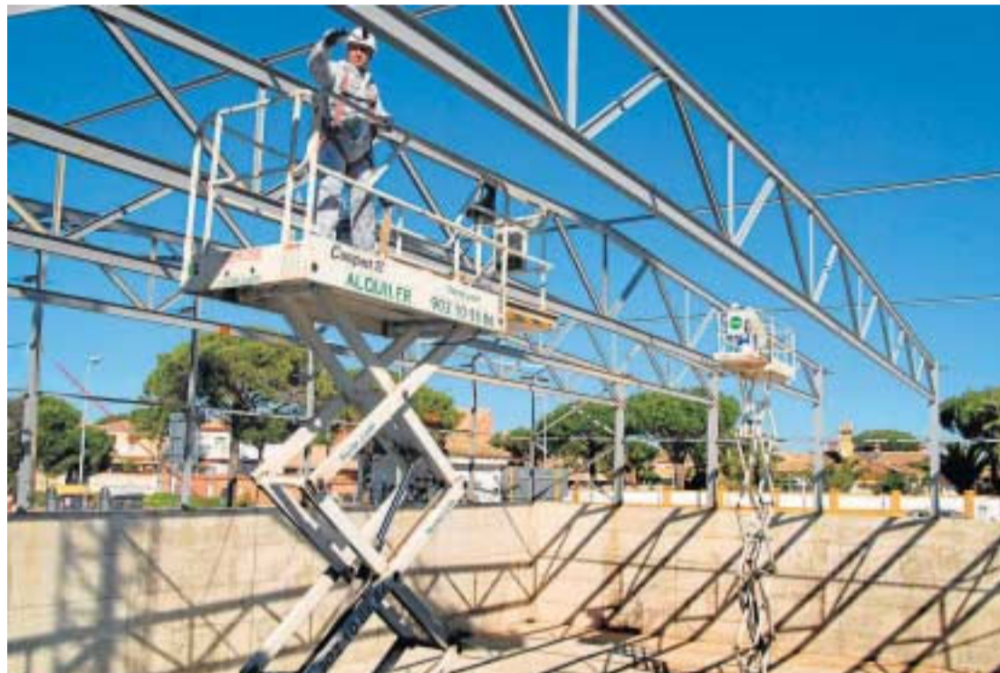
Imagen de las obras del nuevo pabellón de la Costa.
