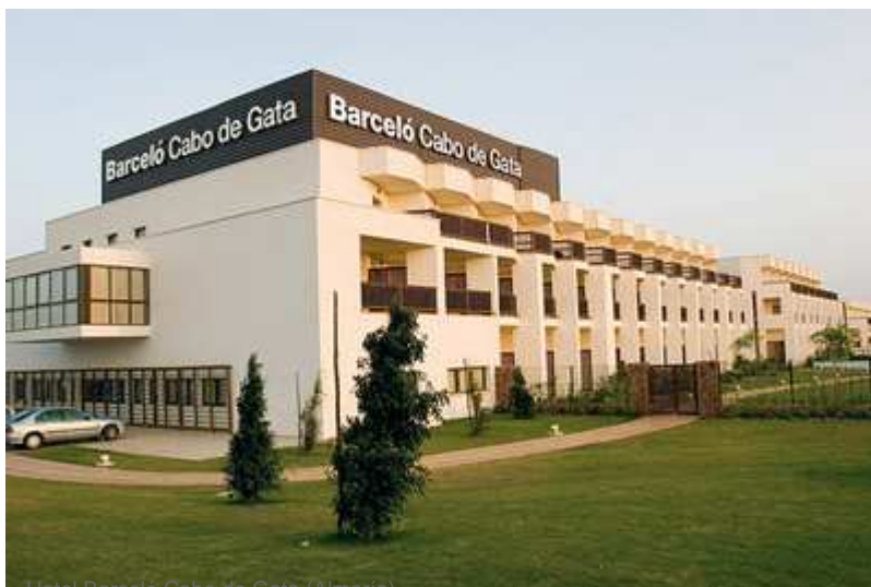
Hotel Barceló Cabo de Gata (Almería).
