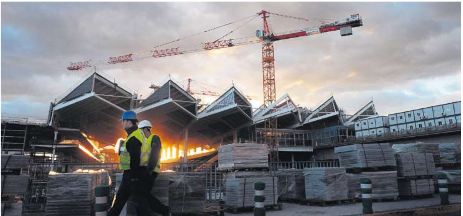
Obras en la estación de Atocha, en Madrid. BLOOMBERG
