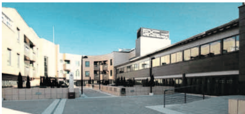
Instalaciones del complejo hotelero Foxá, en la carretera de Madrid, abierto en 2008. :: GRUPO FOXÁ
